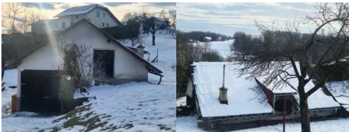
Slika 12 in 13: Dejansko stanje območja, obstoječa stavba gospodarskega poslopja, vir: lastnik parcele
